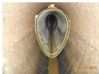
Figure 1 : Principe de réhabilitation par coque complète.
