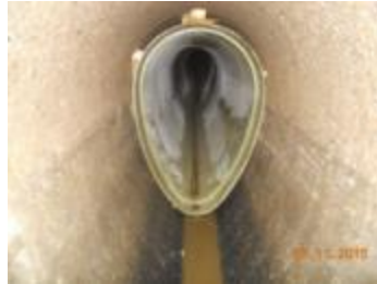
Figure 1 : Principe de réhabilitation par coque complète.
